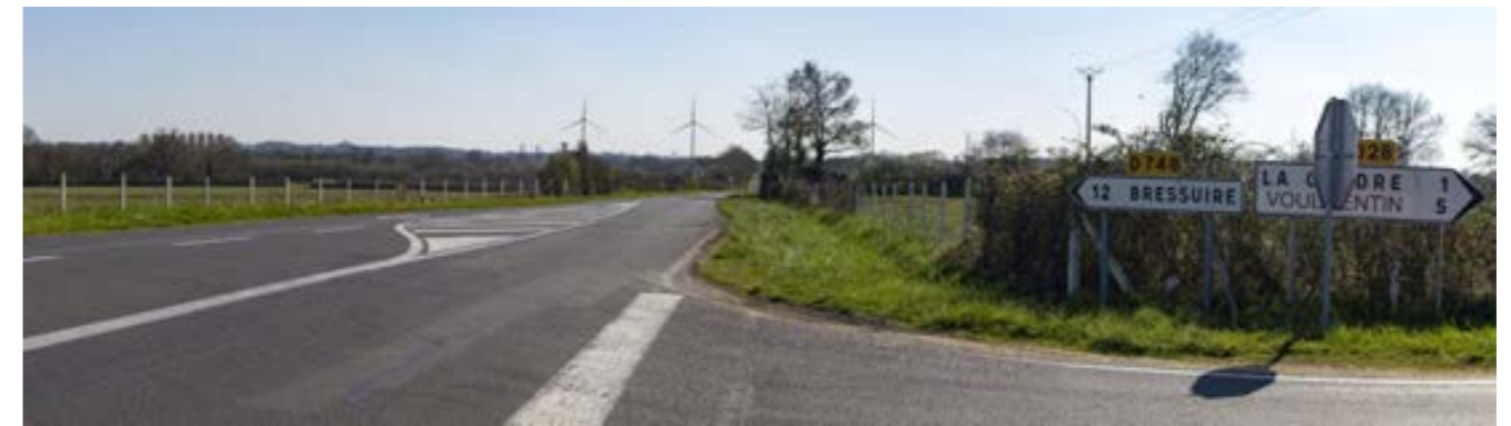
Figure 179 : La variante 1 vue depuis le point de photomontage n°22 (vue réaliste à 60. °)
