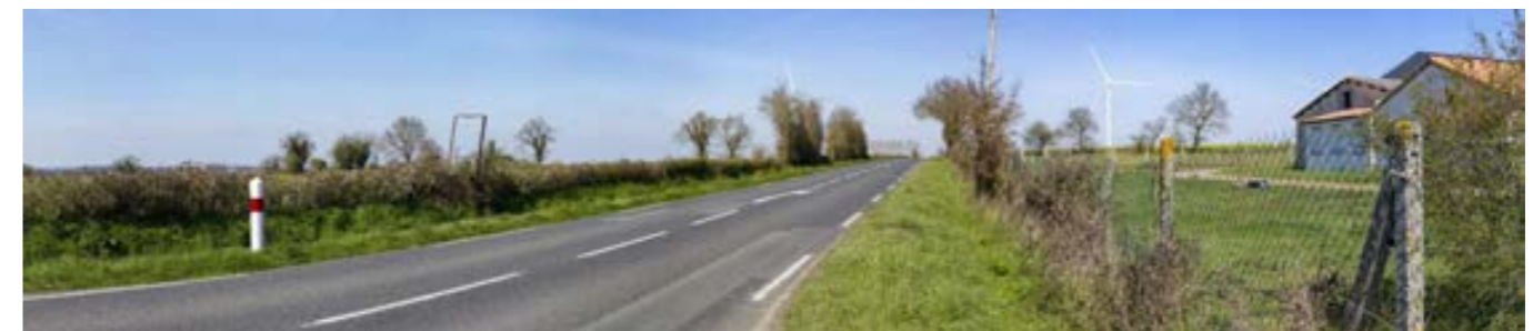
Figure 169 : La variante 3 (retenue) vue depuis le point de photomontage n°07 (vue réaliste à 120°)
